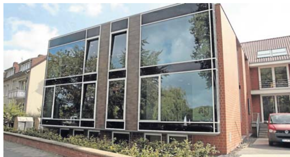
Bodentiefe Fenster sorgen im Gebäude der Apothekerkammer für mehr Transparenz.
